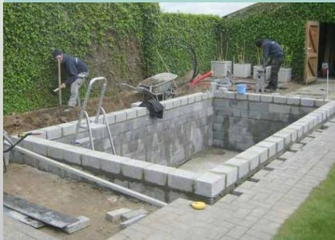
**3** Des blocs de béton sont alors utilisés pour fournir la solidité et renforcer le trou.
