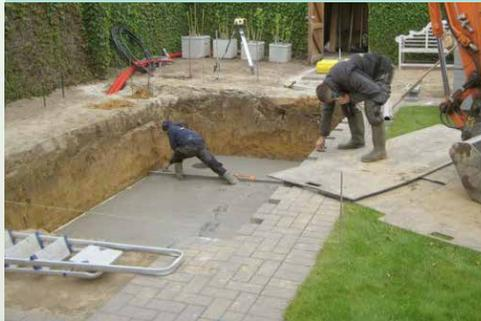
**2** Le trou est creusé et la base en béton est ensuite réalisée.
